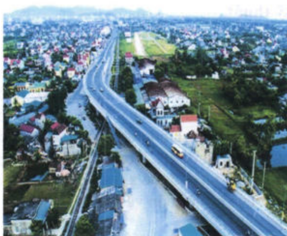
Cầu vượt đường sắt phía Bắc Thành phố Vinh
